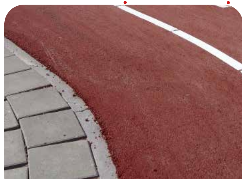
Rode toplaag asfalt
